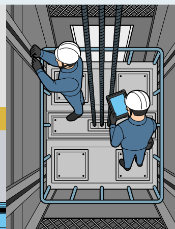
エレベーターの点検
