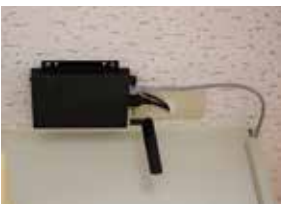
天井面に取り付けられたデジタルサイネージ用STB（セットトップボックス）。
